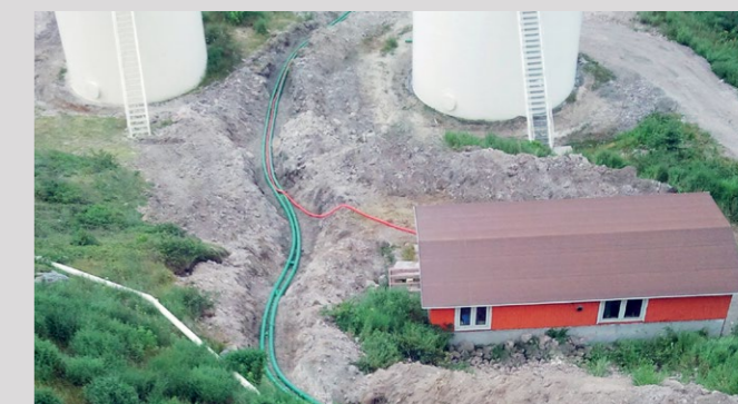
Tepelná elektrárna EDF, Saint Pierre, Francie
