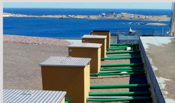
Tepelná elektrárna, Francie
