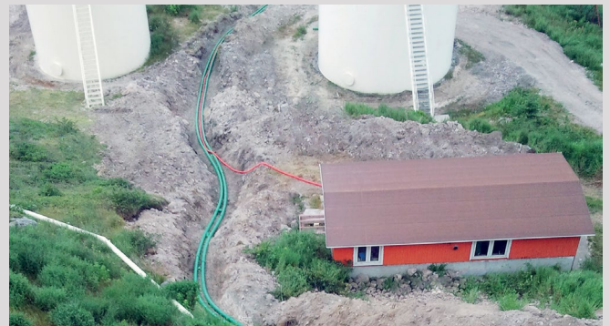
Générateur turbine à carburant (Ethanol/gasoil) EDF la Réunion
