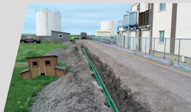
Tanques de almacenamiento de combustible, Francia
