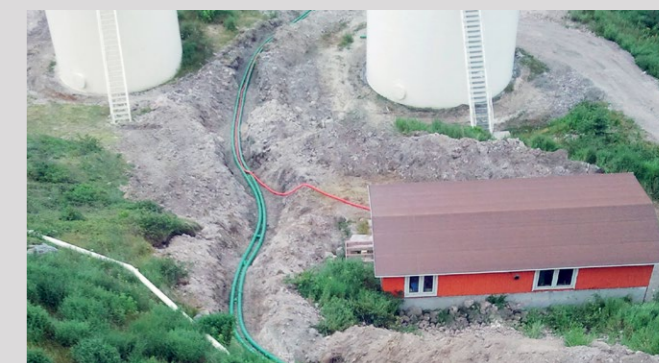
Planta de energía térmica EDF, Saint Pierre, France
