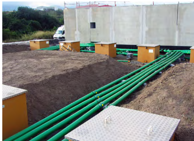
Les tuyaux KPS sont conducteurs et évitent la création et l'accumulation des charges électrostatiques
