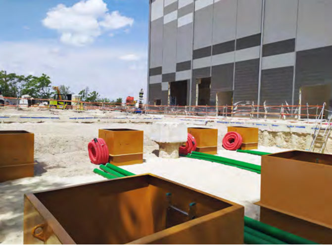
KPS 2" (75/63mm) iletken çift cidarlı borular, yakıt depolarını yedek jeneratörlere bağlamak için kullanıldı
