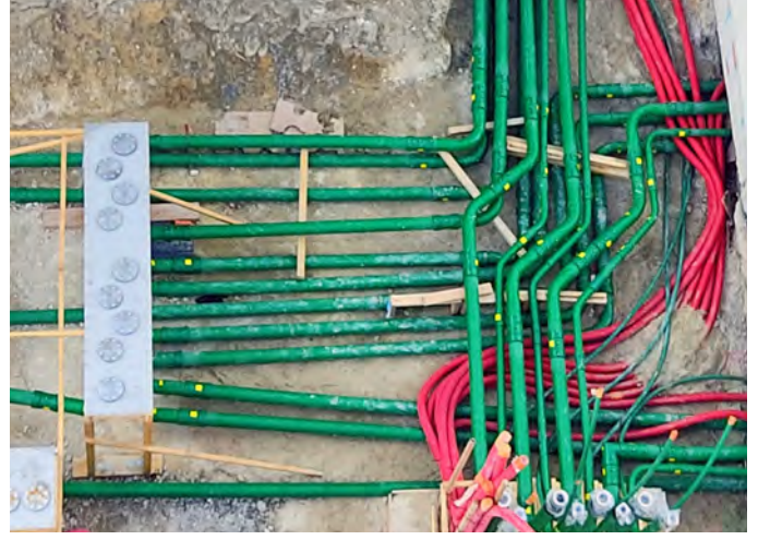
İletken KPS boruları elektrostatik olarak güvenlidir ve potansiyel static elektrik birikimi önler
