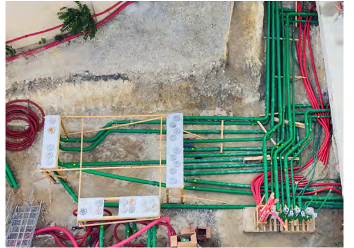
Uzak dolum noktalarını ve yer altı yakıt tanklarını bağlamak için KPS' 4" (125/110mm) çift cidarlı boru tesisatı kuruldu
