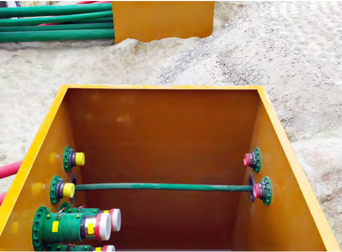
KPS 4" boru sistemi, 933 litre/dakika akış hızı sağlar
