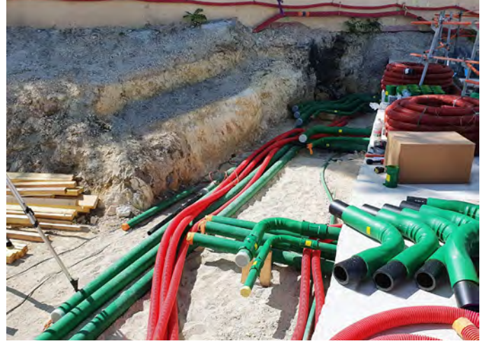
KPS'nin çift cidarlı boru sistemi, iç ve dış borular arasında ekstra bir güvenlik katmanı sağlayan bir ara boşluk içerir
