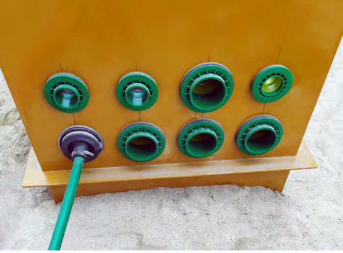
Sıvı geçirmez KPS boru giriş contaları, yakıt kaçağına ve yeraltı suyu girişine karşı tam koruma sağlar
