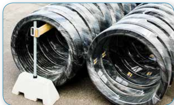
Lorsque les couronnes sont stockées verticalement, elles doivent être soutenues pour éviter la déformation du tuyau.
