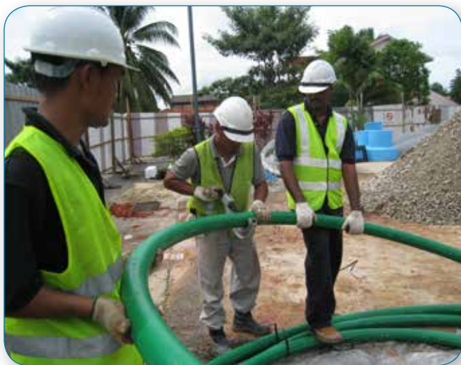
Une personne doit maintenir le tuyau et une autre doit faire la coupe.
