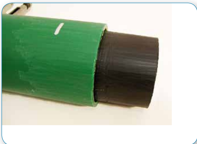
Tuyaux correctement grattés. L'oxyde a été supprimé de la totalité de la zone à souder.
