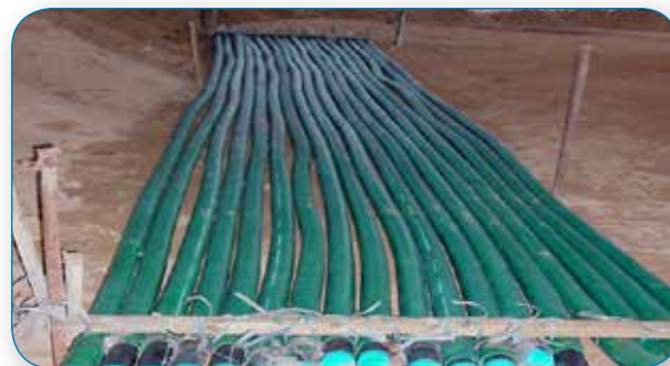
Redressement de couronnes.
