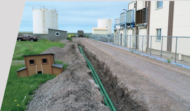
Tanques de almacenamiento de combustible, Francia
