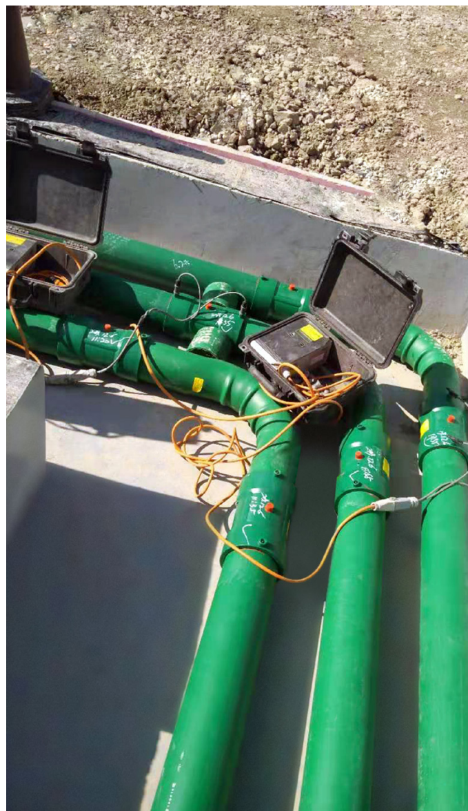
La soudure par électrofusion KPS garantit que le système de tuyauterie a une perméation nulle, (complètement étanche aux liquides/à l'eau).
