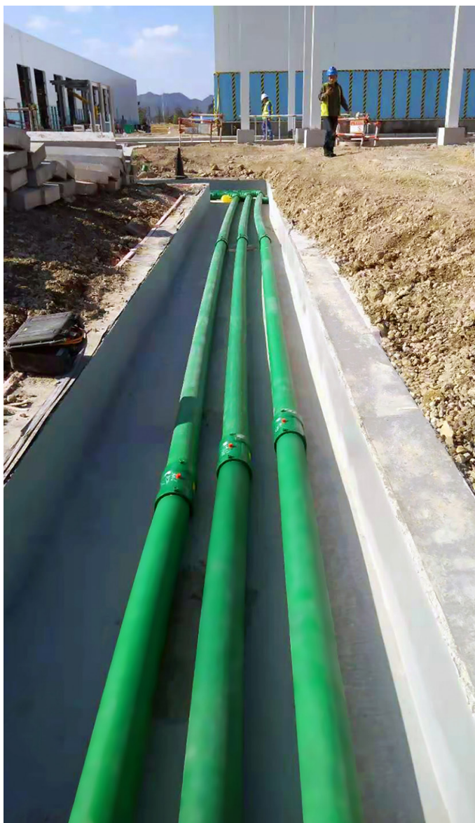
La tuyauterie à double paroi de KPS comprend un espace interstitiel, offrant une couche de sécurité supplémentaire.
