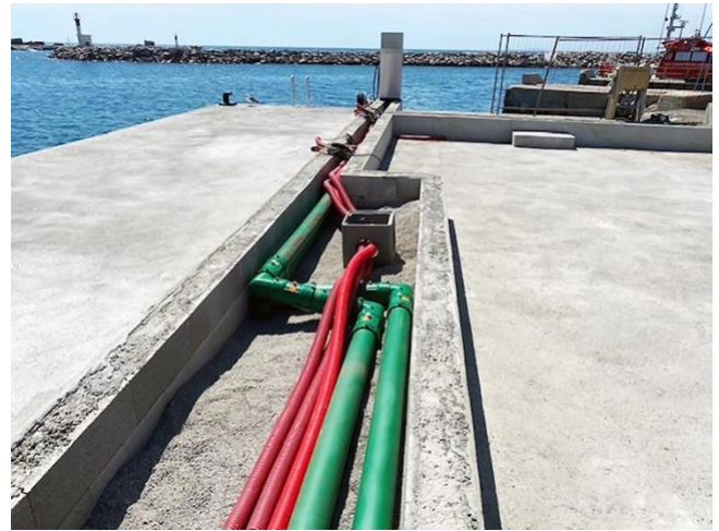
تُعتبر أنابيب KPS الموصلة آمنة من الناحية الكهروستاتيكية، مما يمنع أي تراكم محتمل للكهرباء الساكنة
