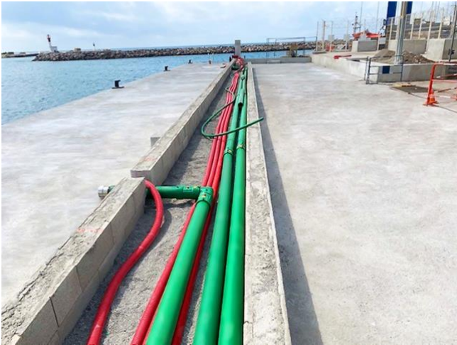
وفر أنبوب KPS ذو الجدار المزدوج مقاس 4 بوصات (125/110 ملم) معدل تدفق يبلغ 933 لترًا/دقيقة
