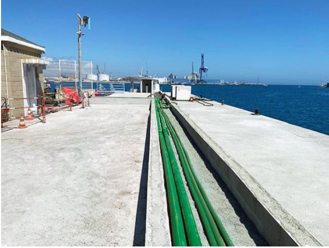
تتيح أنابيب KPS بقياس 4 بوصات معدل تدفق يبلغ 933 لترًا/دقيقة، مما يُمكن من توصيل الوقود بسرعة
