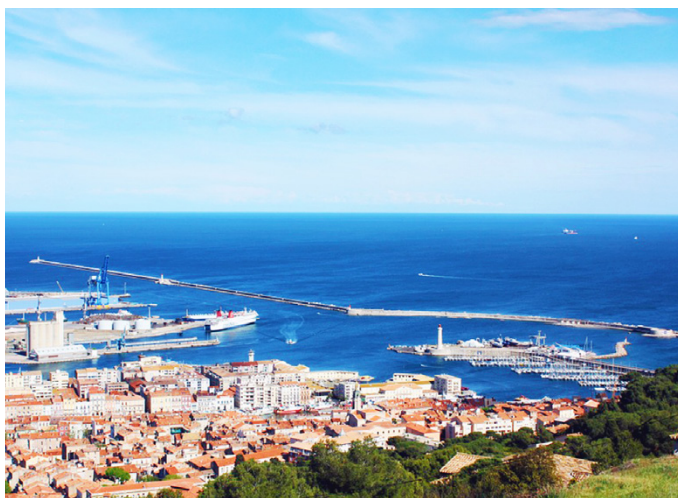
Le remplacement à long terme des tuyaux en acier corrodés du port de Sète, Montpellier était nécessaire
