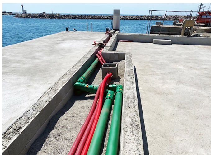
La canalisation conductrice KPS est protégée sur le plan électrostatique, empêchant l'accumulation potentielle d'électricité statique
