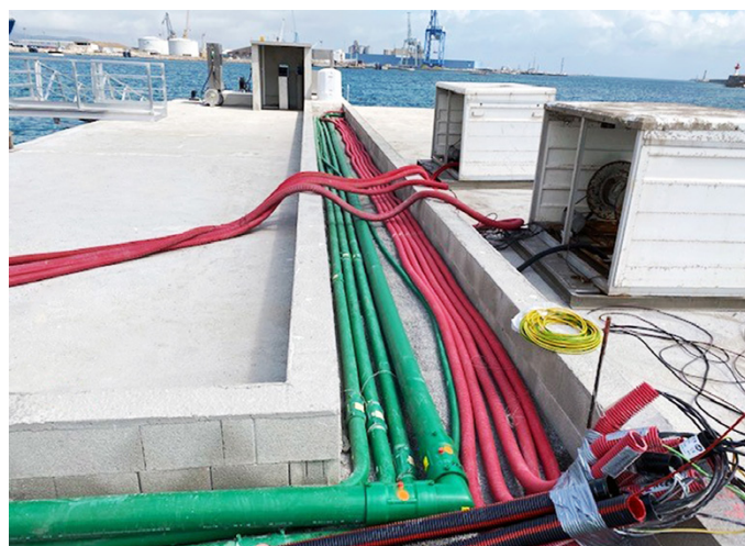
La canalisation KPS est conçue pour une installation rapide et simple
