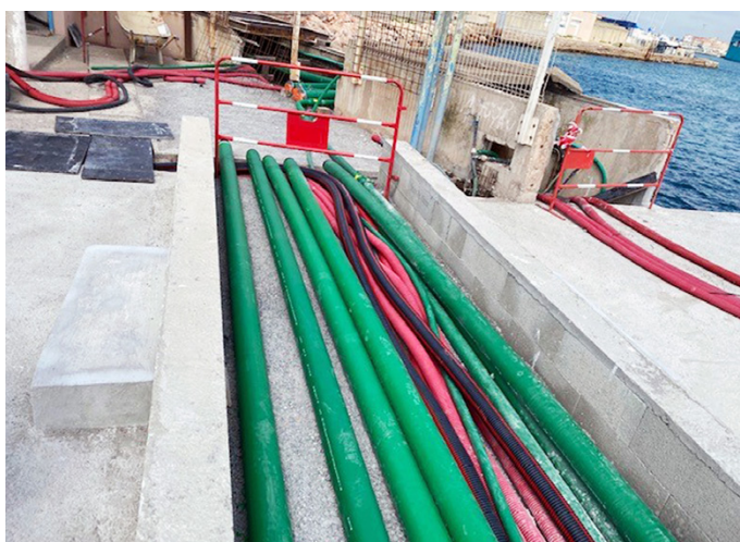
La canalisation KPS comprend une barrière de perméation EVOH et une couche conductrice de noir de carbone
