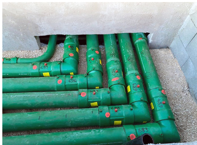
Les coudes de canalisation à 90° de KPS 4" à double paroi sont une solution compacte pour les projets où l'espace est restreint
