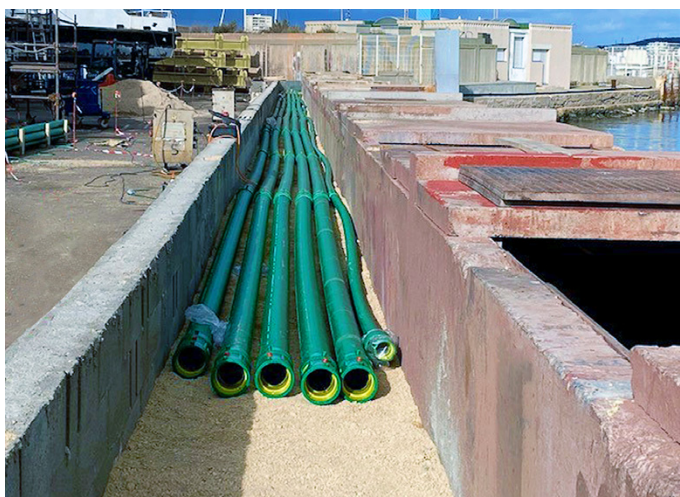
La canalisation à double paroi de KPS est constituée d'un espace interstitiel entre les tuyaux intérieur et extérieur, offrant une couche de sécurité supplémentaire
