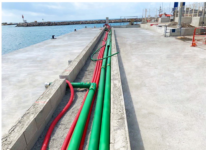
La canalisation à double paroi KPS 4" (125/110 mm) fournit un débit de 933 litres/min
