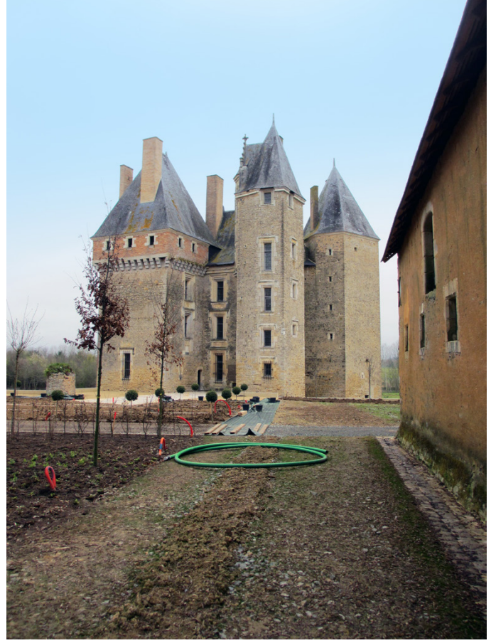
KPS, şatodan 60 metre uzaklıkta, KPS iletken çift cidarlı boru sistemi ile dizel yakıt deposuna bağlı bir uzaktan dolum noktası kurdu.
