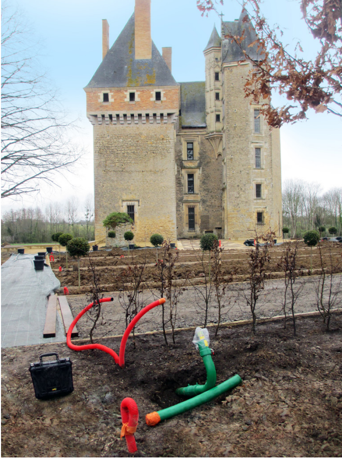
KPS, dizel yakıtlı merkezi ısıtma sistemleri için uzaktan doldurma sistemi tasarlamak ve kurmak için Château de Verdelles (Fransa) üzerinde çalıştı.
