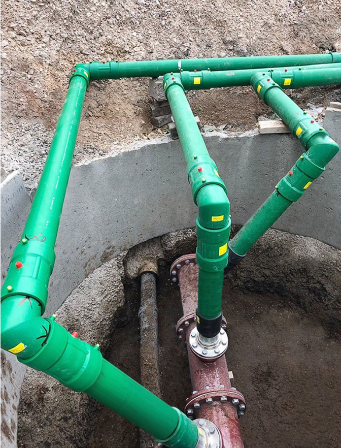
Kompakt kalıplanmış dirsekler, yeni KPS borularından daha önce inşa edilmiş olan yakıt borularına bağlantı sağlar
