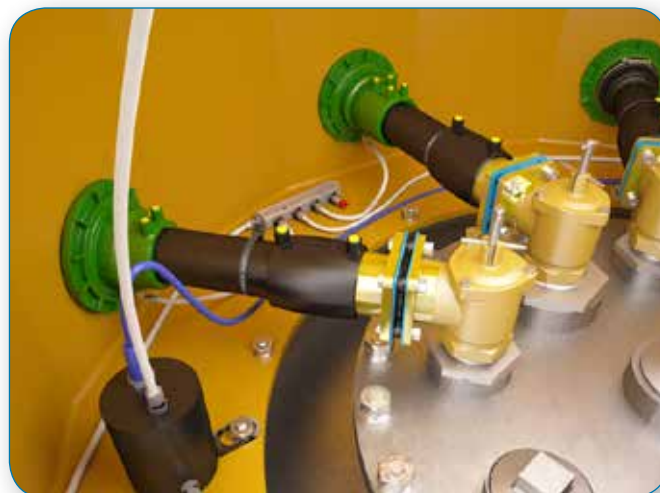
Le système de détection des fuites KP 315.
