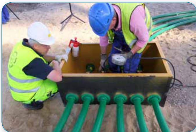
Christian Niejahr OPW Suède, assiste un installateur sur site.
