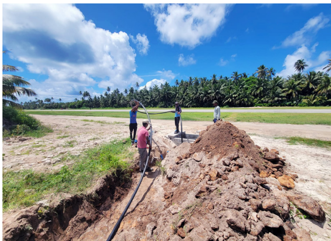
Préparation du système de canalisation KPS à installer dans une tranchée aux Seychelles.
