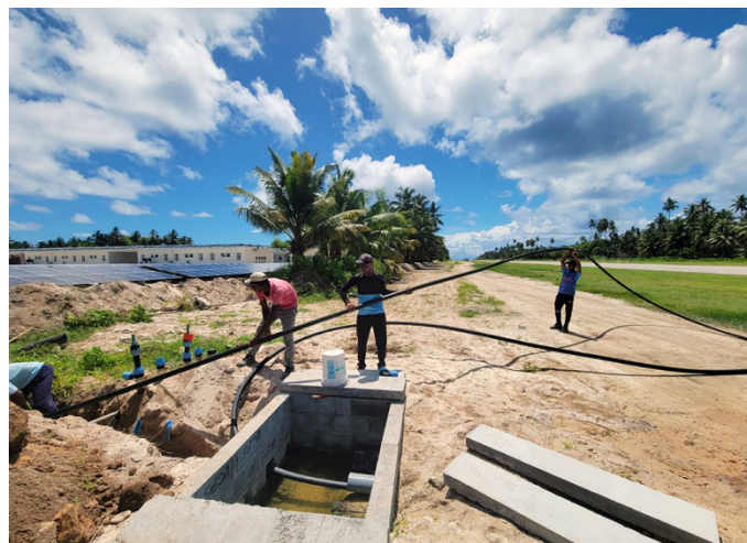
Traversée de la piste d'aviation de l'île des Seychelles pour connecter la canalisation de ravitaillement.
