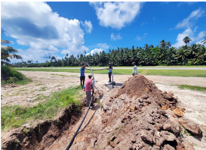
Förbereder KPS-rör som ska installeras i ett dike på Seychellerna.
