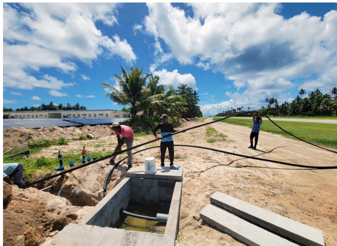
Korsar Seychellernas landningsbana för att ansluta tankningsrörledningen.
