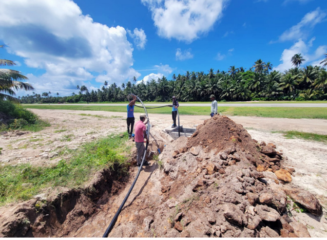
Seyşeller'deki bir hendeğe yerleştirilecek KPS borularının hazırlanması.
