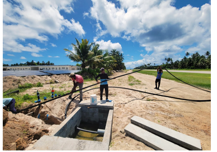
Yakıt ikmal boru hattını bağlamak için Seyşeller adasının pisti altından geçiş.
