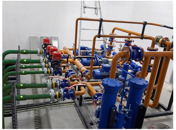
La tubazione conduttiva di KPS è elettrostaticamente sicura, evitando il potenziale accumulo di cariche statiche
