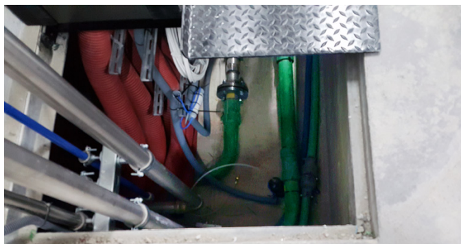
Le tubazioni KPS consentono la portata di carburante di 933 litri/minuto richiesta per fornire diesel alla flotta di autobus
