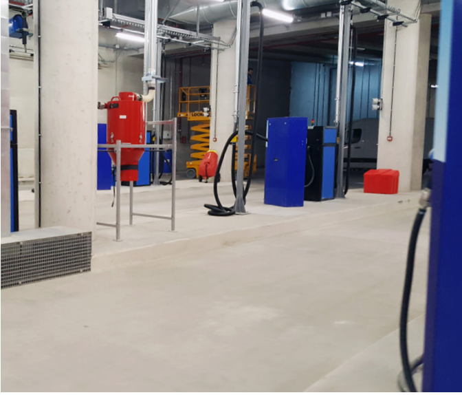
Dolum noktaları kapalı garaj içerisine kurulduğundan kaçaksız sıfır geçirgen bir sistem gerekiyordu.
