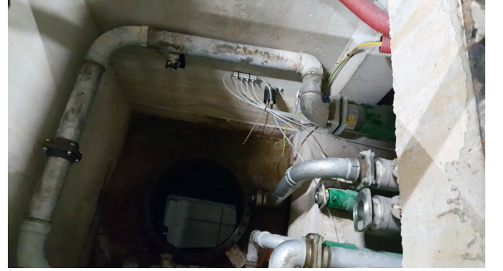
İç ve dış borular arasındaki kesintisiz cidar boşluğu işletmecilere KPS sızıntı tespit sistemi ile izleme imkanı sağlar.
