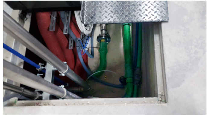
KPS boru tesisatı otobüs filolarına özel hızlı dizel yakıt dolumu için gereken 933 lt/dak lık yakıt akış hızına imkan sağlar.
