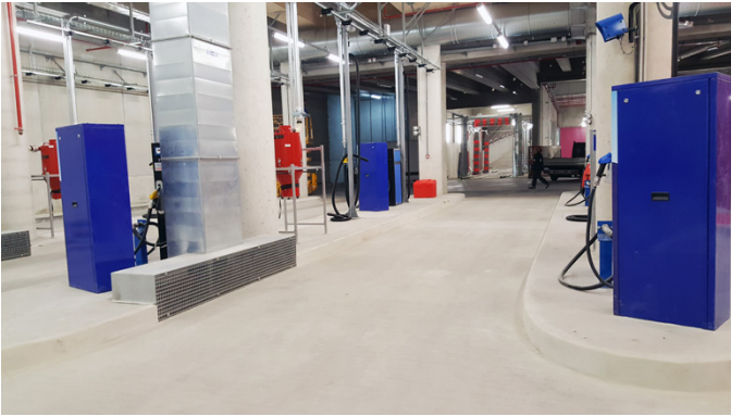
RATP, otobüs filosuna hızlıca dizel ikmal edebilmek için akış hızı yüksek olan bir boru tesisatına ihtiyaç duymaktaydı.
