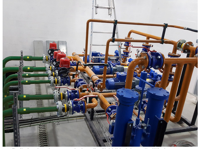
KPS'in iletken boruları potansiyel statik yük birikimini engellediğinden elektrostatik olarak güvenlidir.
