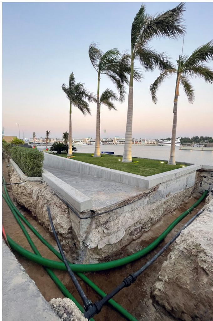
Le système de canalisation KPS ne réagit pas à l'eau salée, éliminant ainsi le risque de corrosion
